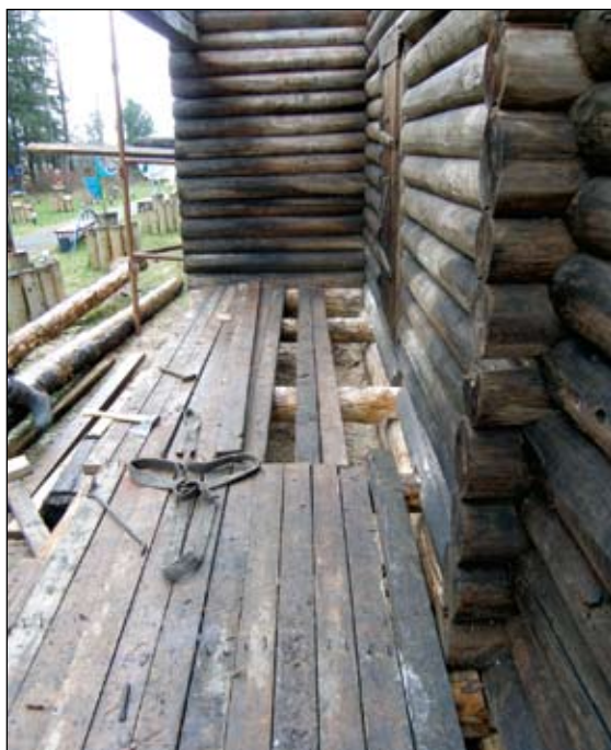
Ил. 37. Завершение монтажа сруба постройки на территории музея «Торум маа» в г. Ханты-Мансийске. 12.10.2015. Фото: Я.А. Яковлев
