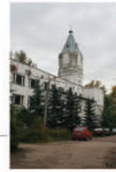
Колокольный перекресток Иоанна Предтечи (1876 г.) - Гаршина ул., 30
