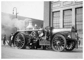
Передвижная паросиловая установка, состоящая из котла, монтированной на нём паровой машины и вспомогательных устройств.
