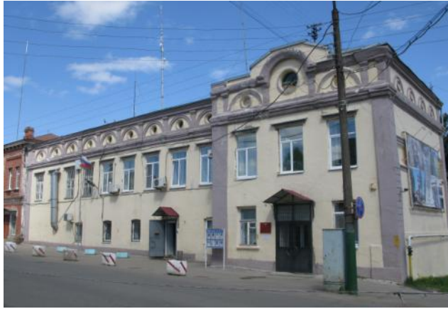
Ул. Шмидта, 13 Общий вид
