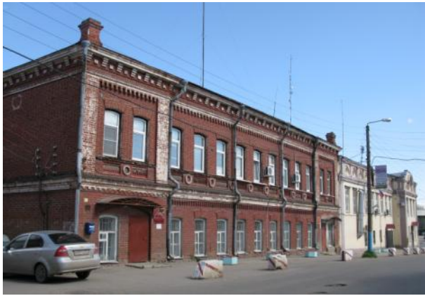
Ул. Шмидта, 11, 13 Общий вид
