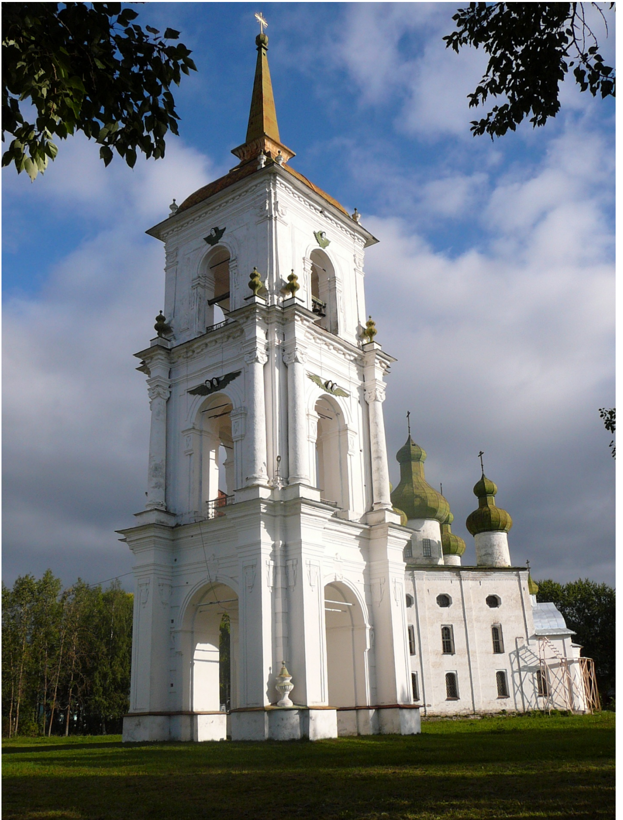
Рис. 52. Соборная колокольня и храм Иоанна Предтечи в Каргополе. (2012). Колокольня была воздвигнута после пожара 1765 года на казённые средства при Екатерине II. Крест на колокольне установлен не по сторонам света, как положено, а в сторону Петербургского тракта, по которому ожидался приезд императрицы. Но её визита здесь так и не дождались. Ныне колокольня в составе музея. Внутри её стен устроены ступени каменной лестницы, по которой можно подняться на смотровую площадку с колоколами. Колокола звучат повседневно и в дни фестивалей колокольного звона.
