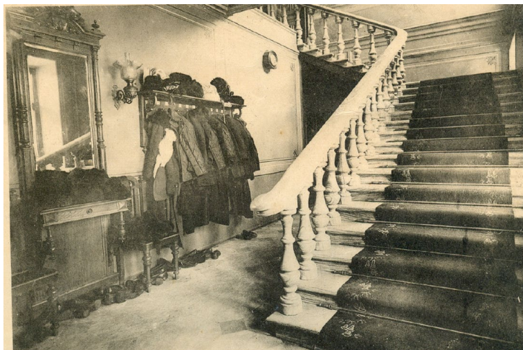
Лестница на второй этаж
