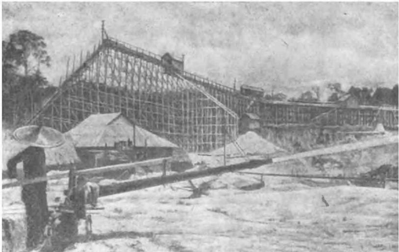
*Россыпи оловоносных песков на Малаккском полуострове размываются гидромонитором (водяной пушкой). Размытая масса течет по специальным канавам. Рудник Иогоре-Багру. 1940 г.*
