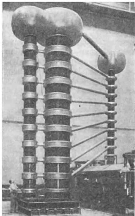
Внешний вид большой трубы для ускорения ионов с каскадной схемой умножения напряжений
