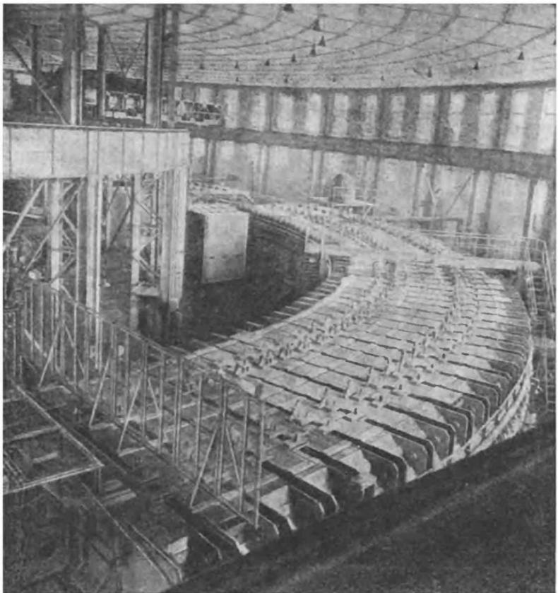
*Часть магнита синхрофазовольтрана на 10 Бэв*
