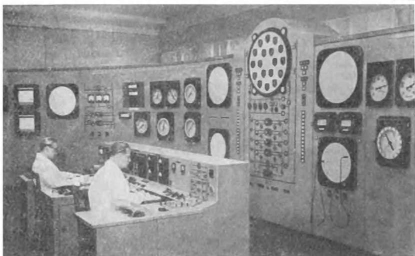
*Пульт управления первой промышленной атомной электростанции. Мощность ее 5 тыс. квт. В сутки АЭС расходует всего 30 г урана-235 (вместо 100 т угля). Управление атомным котлом и всеми другими агрегатами станции производится с общего пульта управления. Вырабатываемый атомной станцией электрический ток поступает для промышленности и сельского хозяйства прилегающих районов*
