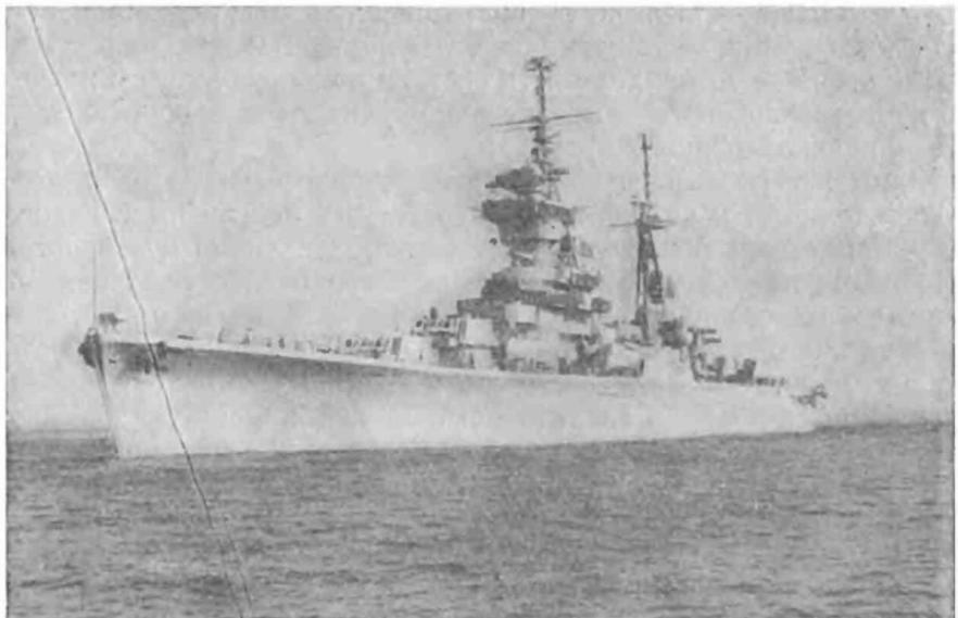
*Крейсер «Свердлов», корпус которого построен из легированной стали.*
