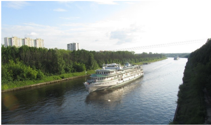
Теплоход на канале им. Москвы у пос. Водники (2018)
