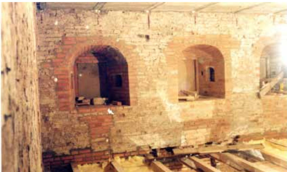
118. Больничные кельи с церковью Двенадцати апостолов. Ниши-шкафчики для хранения лекарств в откосах оконных проемов. Фото Е. В. 2005
