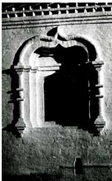
142. Казенные кельи. Северный фасад. Наличник оконного проема после реставрации. Фото Е. В. 1979
