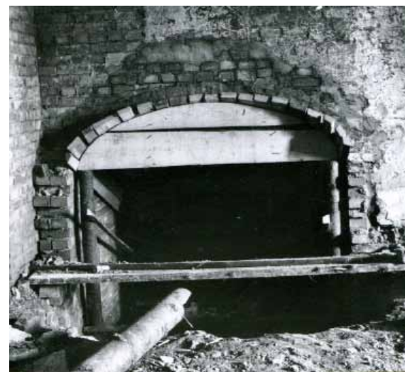
137. Архимандричьи кельи. Выход внутренней лестницы на 2-й этаж в процессе реставрации. Аналог для реставрации Южных келей. Фото Е. В. 2005
