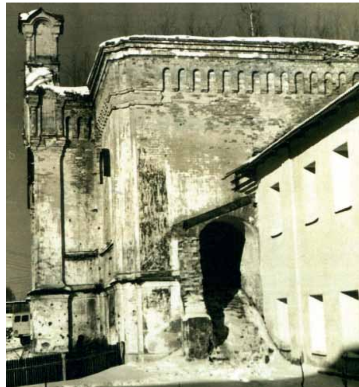
98. Крестовоздвиженская церковь. Южный фасад с утраченным объемом крыльца. Фото ЛО СНРПМ. 1964. Архив СПР
