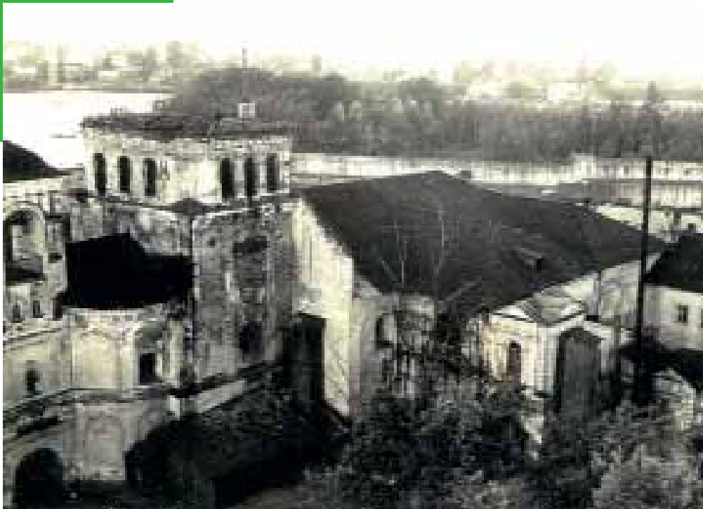
42. Трапезная палата с Покровской церковью. Фото ЛО СНРПМ. 1964. Архив СПР
