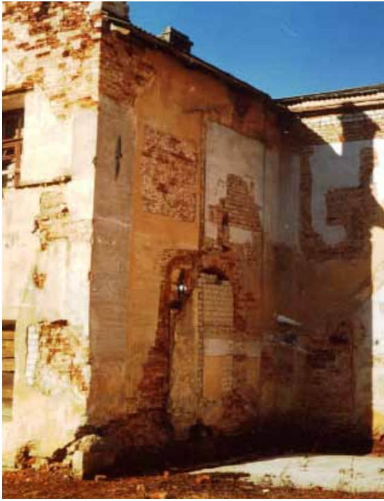
108. Больничные кельи. Церковь Двенадцати апостолов. Северный портал дверного проема с килевидным наличником. Этапы ремонтов, смены стиля и декора. Фото Е. В. 2003
