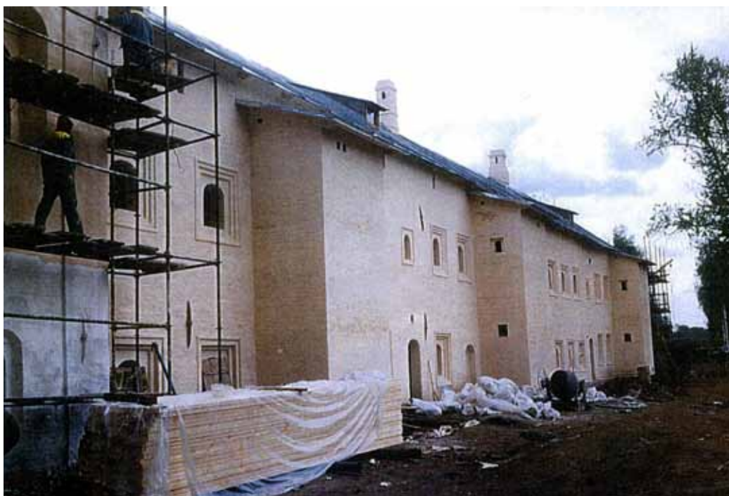
125. Южные братские кельи. Южный фасад после реставрации. Фото Е. В. 2004
