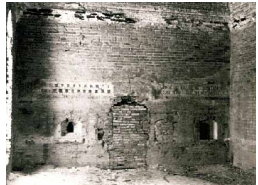
117. Больничные кельи с церковью Двенадцати апостолов. Северный фасад. Первоначальные оконные проемы и кирпичный карниз 1678 г., раскрытые при обмерах соседней Крестовоздвиженской церкви. Арх. В.В. Экк. Фото ЛО СНРПМ. 1964. Архив СПР
