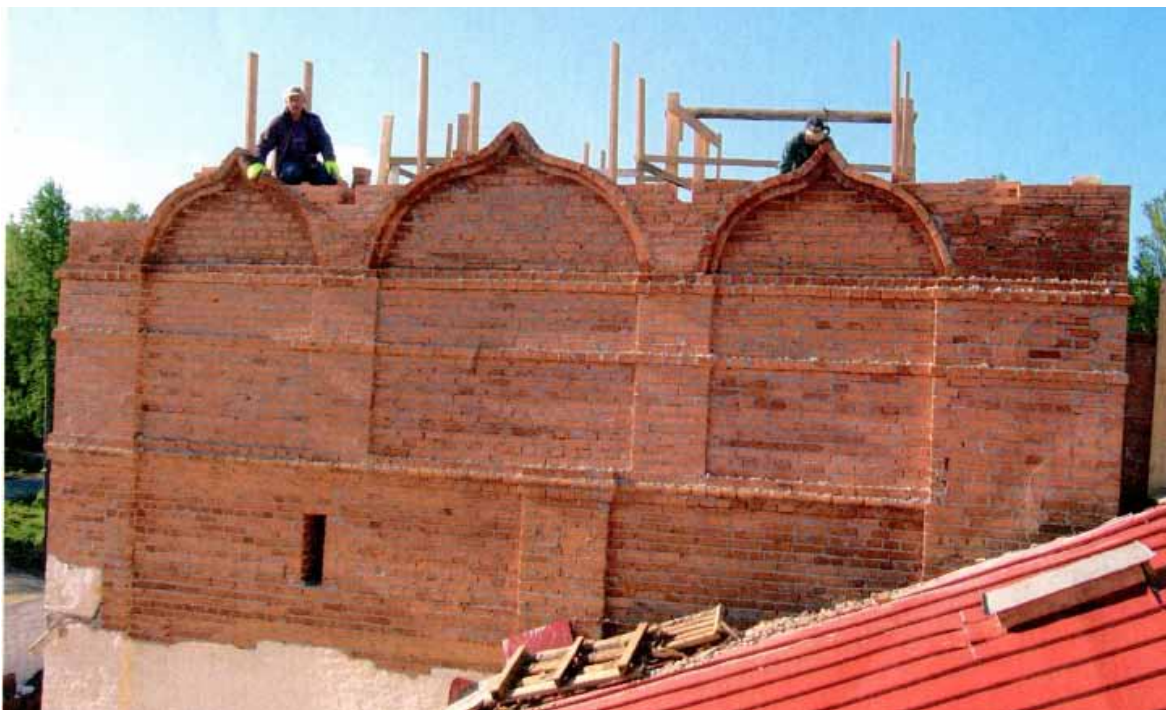
122. Больничные кельи с церковью Двенадцати апостолов. Процесс воссоздания верхней части стен церкви. Фото Е. В. 2005
