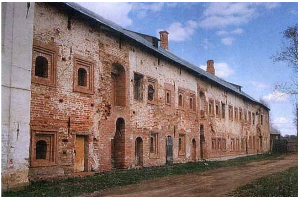
124. Южные братские кельи. Южный фасад в процессе реставрации. Фото Е. В. 1986
