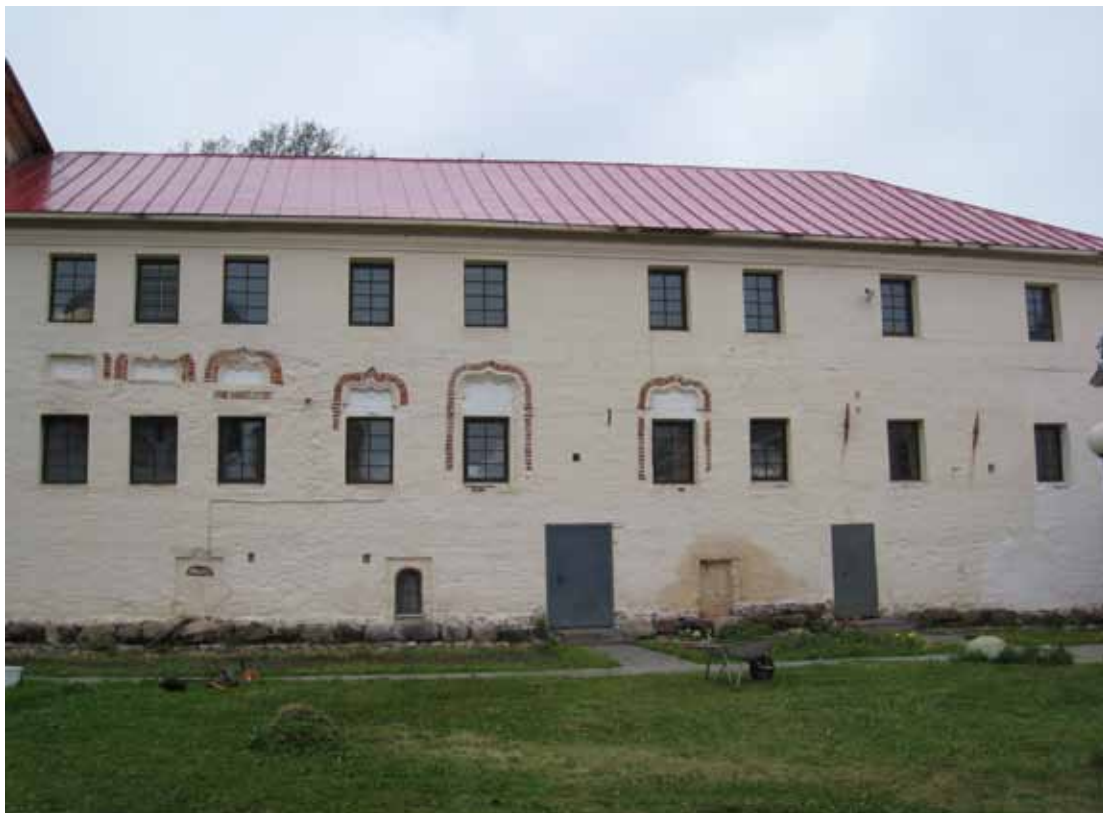
163. Келарские кельи. Восточный фасад после проведения консервационных работ. Фото Т.П. 2007
