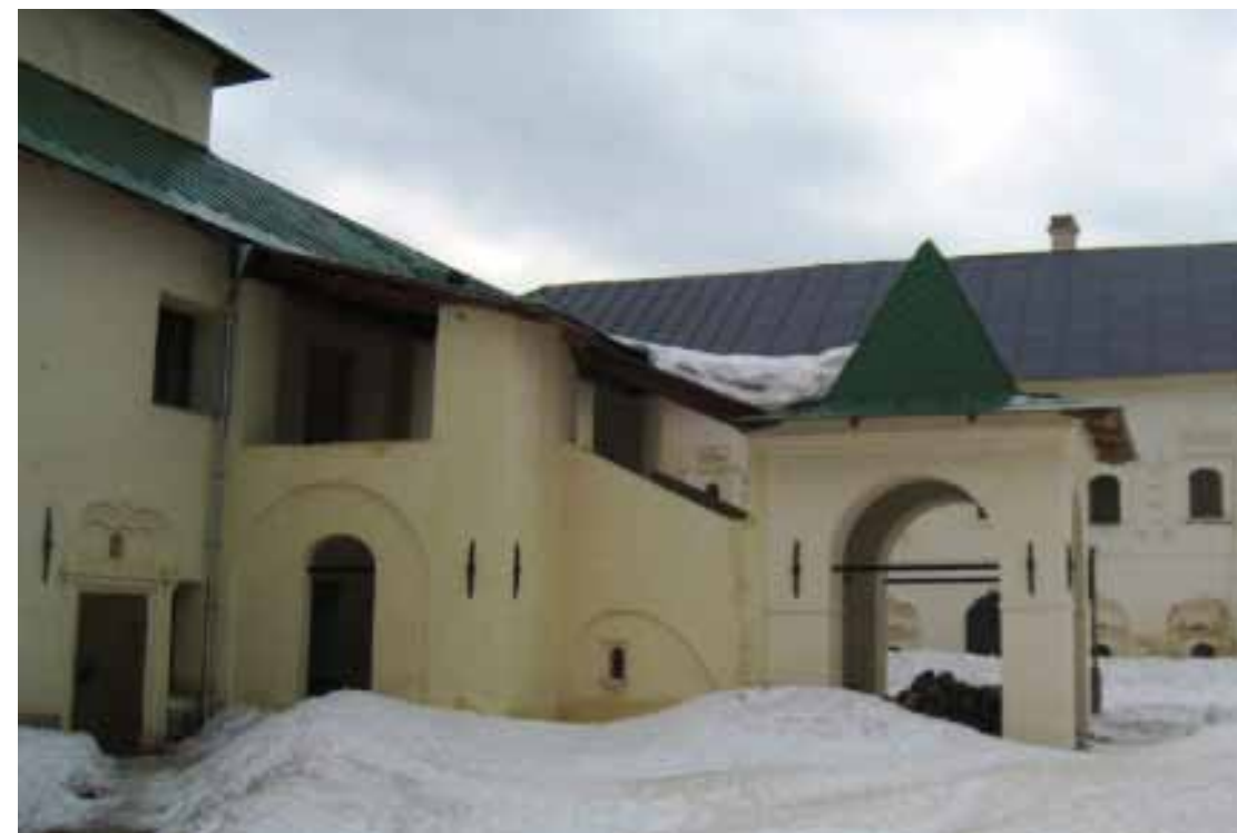
121. Больничные кельи с церковью Двенадцати апостолов. Воссозданный объем крыльца на фундаментах 1676 г. (сравнить – илл. 111). Фото Т. П. 2011
