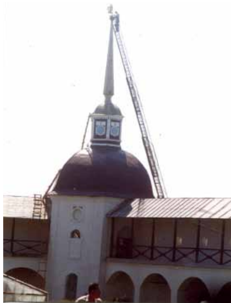
84. Ремонт и покраска завершения угловой юго-западной башни. Фото Е. В. 2004
