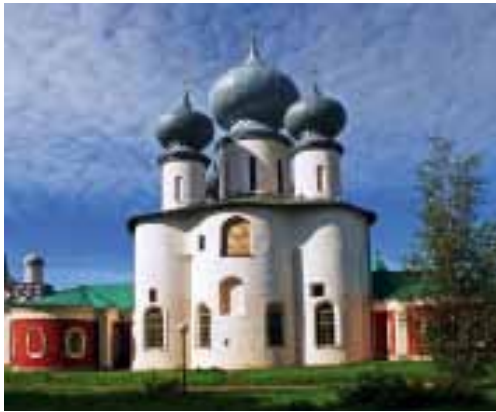
14. Успенский собор. Восточный фасад. В 1979 г. были раскрыты первоначальные оконные проемы на апсидах. Фото Е. В. 2004
