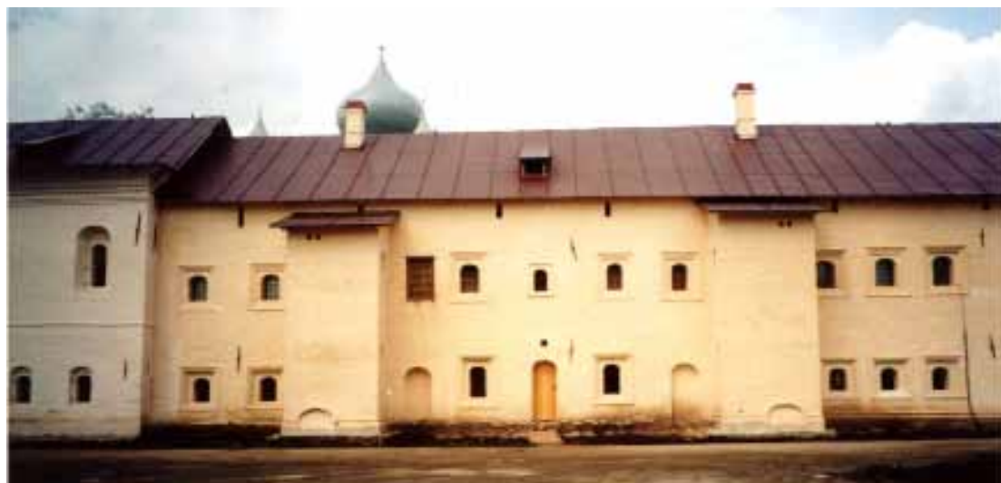
132. Южные братские кельи. Южный фасад после реставрации. Фото Е. В. 2007
