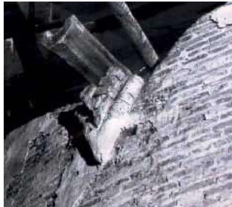
3. Успенский собор. Барабан центральной главы. Древние подлинные детали — кокошник и водомер. Фото Е. В. 1980
