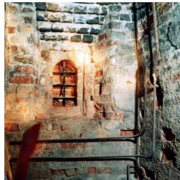
56. Святые ворота. Камера под лестницей. Подлинное окно 1591 г., раскрытое при исследованиях 2002 г. Фото Е. В. 2003
