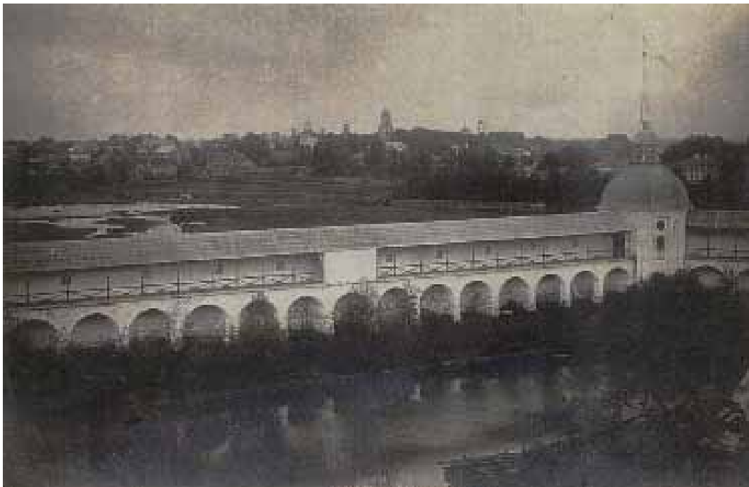
86. Южная стена, юго-западная угловая башня, Таборы и центр города. Фото 1900–1910-х гг. Из колл. Е. В.
