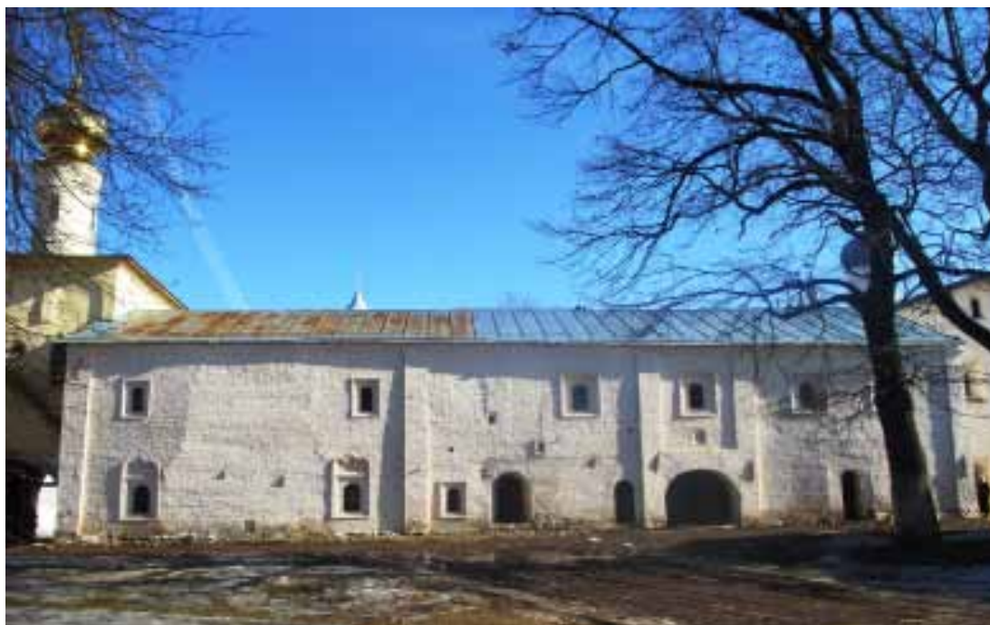
156. Архимандричьи кельи. Западный фасад после реставрации. Фото Е. В. 2010
