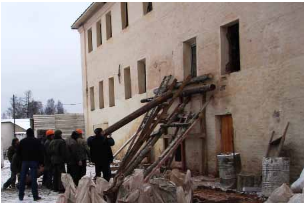
169. Келарские кельи. Противоаварийные работы 2008 г. Выпрямление и закрепление фрагмента кирпичной кладки западной стены. Фото Т. П. 2008
