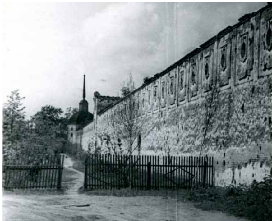
82. Южная монастырская стена. Фото ЛО СНРПМ. 1963. Архив СПР
