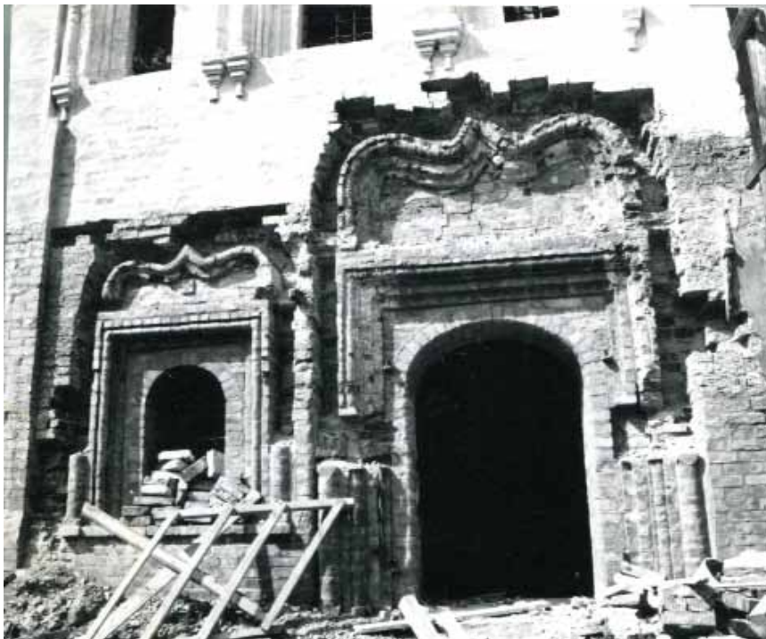
162. Архимандричьи кельи. Портал главного входа и наличник оконного проема на первом этапе реставрации. Фото А.В. Плошко. 1981
