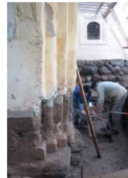
57. Святые ворота с церковью Вознесения и приделом Федора Стратилата. Реставрация цоколя. Фото Е. В. 2004
