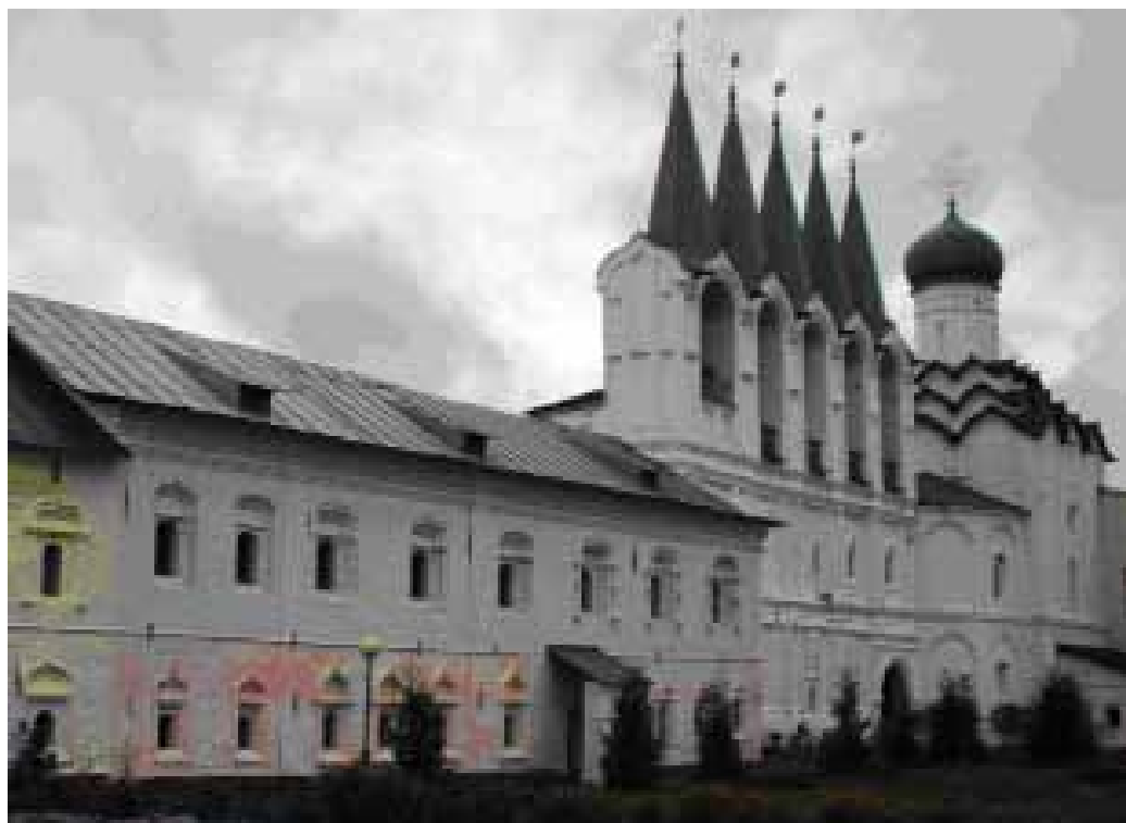
147. Южная линия каре монастырской застройки. Казенные кельи, Звонница, Покровская церковь после реставрации. Фото Е. В. 2005
