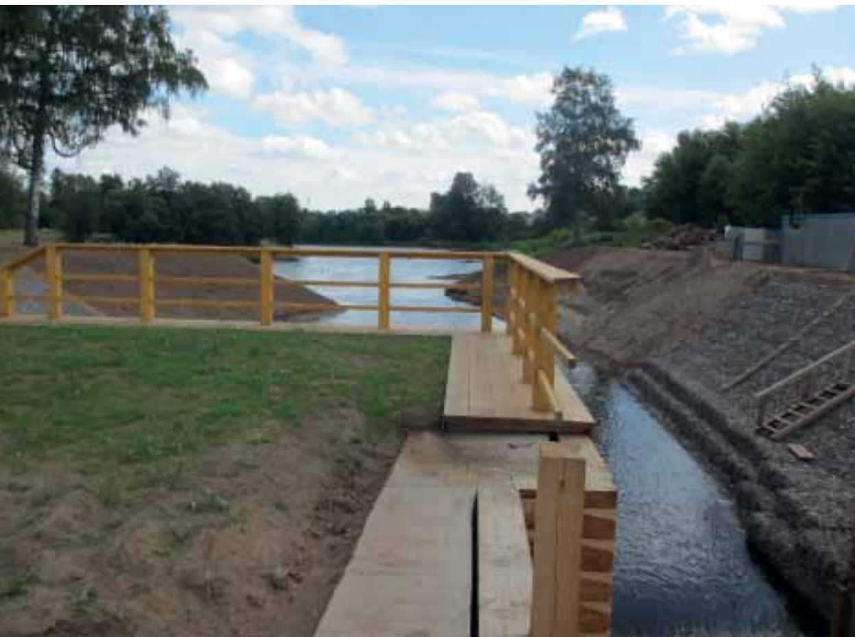
213. Тихвинский шлюз после реконструкции. Фото Е. В. 2015
