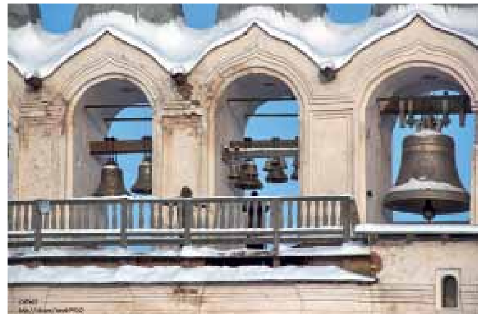
66. Звонница. Южный фасад. Ярус звона. Подвеска колокола за два хомута. Фото Е. В. 2009
